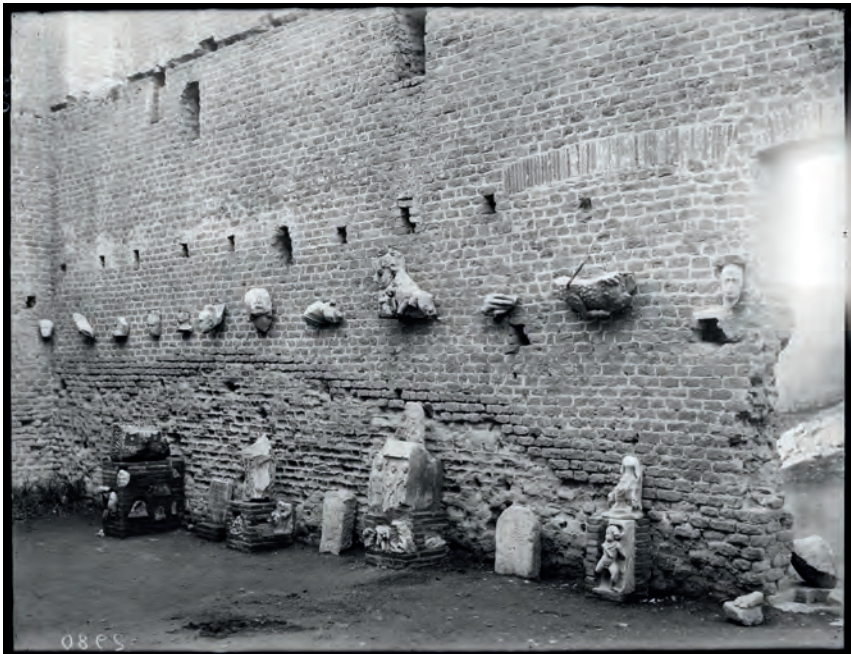
Figura 88. Palazzo Caetani, Ambiente A parete nord-ovest, particolare, GFN, neg. E2980.
